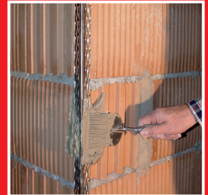
1. Eckschiene setzen
