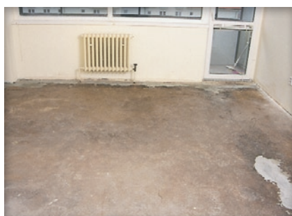
1. Oczyszczone i wyrównane podłoże
