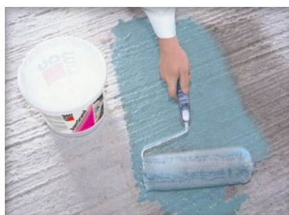
2. Gruntowanie (Baumit SuperGrund)
