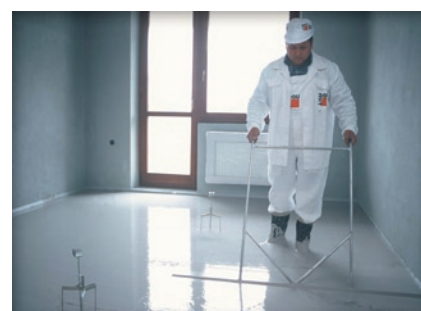
Odpowietrzanie świeżej wylewki
