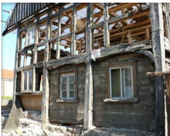
Oczyszczona z wypełnień drewniana konstrukcja muru szachulcowego.
