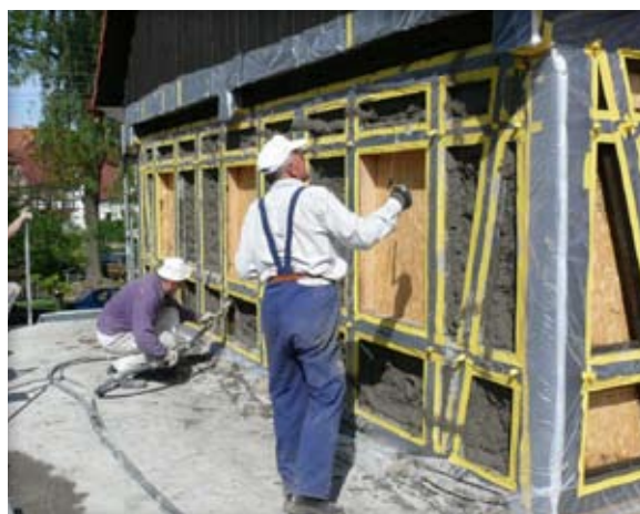
Wypełnienie pól materiałem LTM 81, „zrobotowana” powierzchnia gotowa do wykończenia szpachlą MC 55 W.
