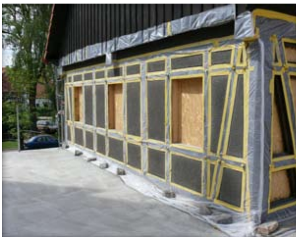
Konstrukcja szachulcowa podczas wypełnienia pól materiałem LTM 81, widoczne jednostronne szalowanie, płyta OSB, trójkątne listwy wewnątrz belek oraz zabezpieczenie drewna przed zabrudzeniem zaprawą.
