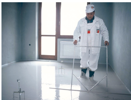
Dezaerarea cu ajutorul barei de dezaerare
