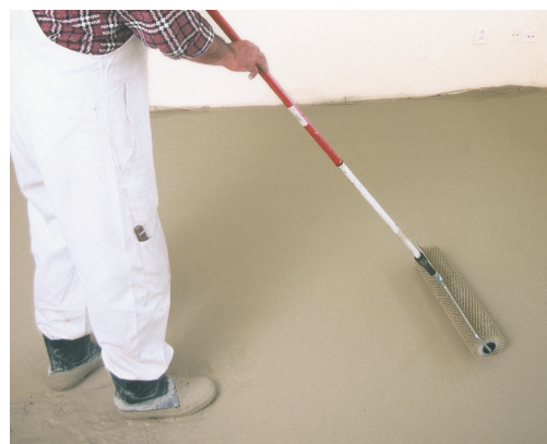
Dezaerarea șapei cu ajutorul trafaletului cu țepi
