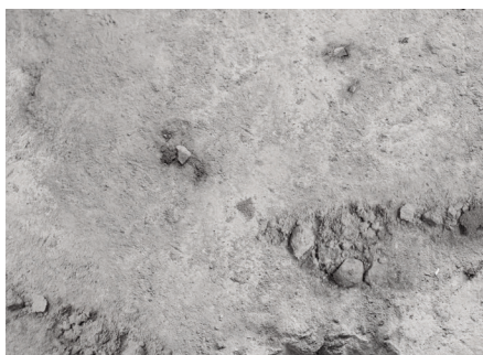
Denivelările și impuritățile ar trebui să fie eliminate
