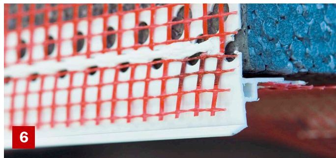
6 Poziționarea corectă a profilului.
