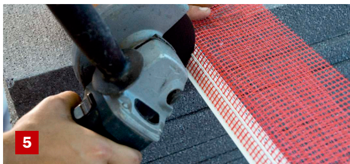
5 Tăierea profilului se realizează cu polizorul unghiular.
