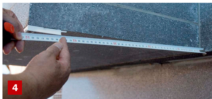
4 Măsurăm lungimea necesară pentru profilul cu lăcrimar.
