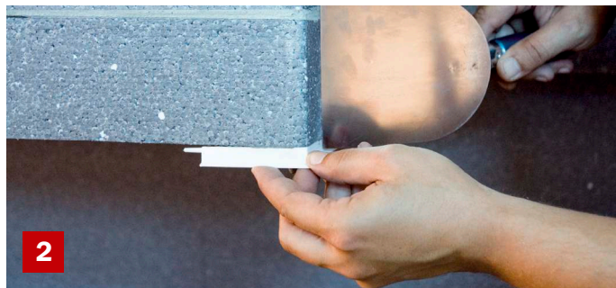
2 Piesa de îmbinare colț exterior pentru profil muchii orizontale cu lăcrimar se montează pe termoizolație.
