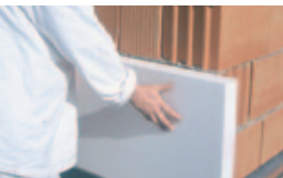
aj v oblasti zatepfovania budov.
