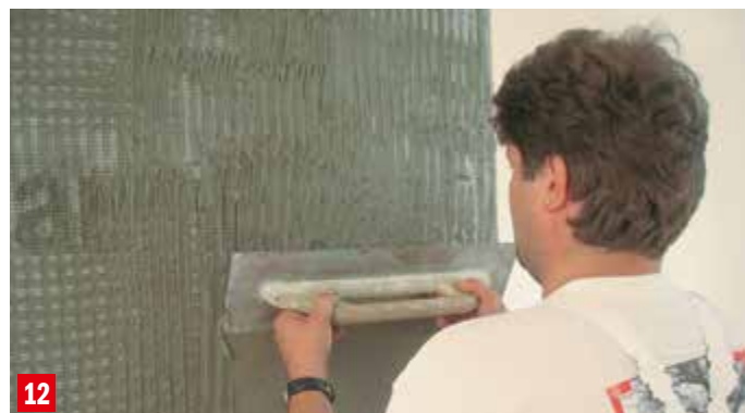
12 Po zahladení a stiahnutí prebytočnej lepiacej stierky má byť hrúbka výstužnej vrstvy 3 – 5 mm, min. však 3 mm.
