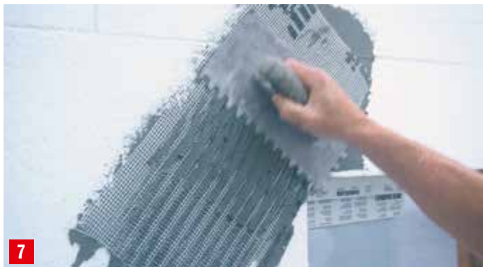
7 V rohoch otvorov sa na prenesenie šikmých šmykových napätí ukladá pred realizáciou výstužnej vrstvy navyše prídavná diagonálna výstuž veľkosti min. 300 x 200 mm.
