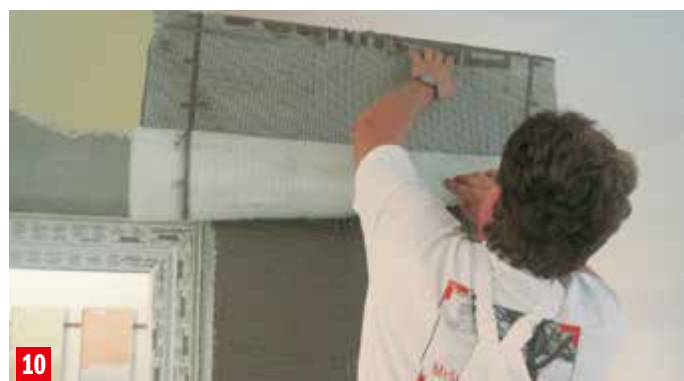
10 Do vrstvy lepiacej stierky sa vkladá sklotextilná mriežka. Jednotlivé kusy sklotextilnej mriežky sa spájajú s presahom min. 10 cm.
